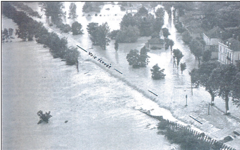
Figure n° 4 : Vue aérienne de la crue du 8/07/1977 à Montestruc - A cet endroit, la voie ferrée traverse la vallée du Gers en remblai. Le remblai est submergé et la photo met en évidence le rehaussement de la ligne d'eau (surcote) qu'il provoque côté amont.
