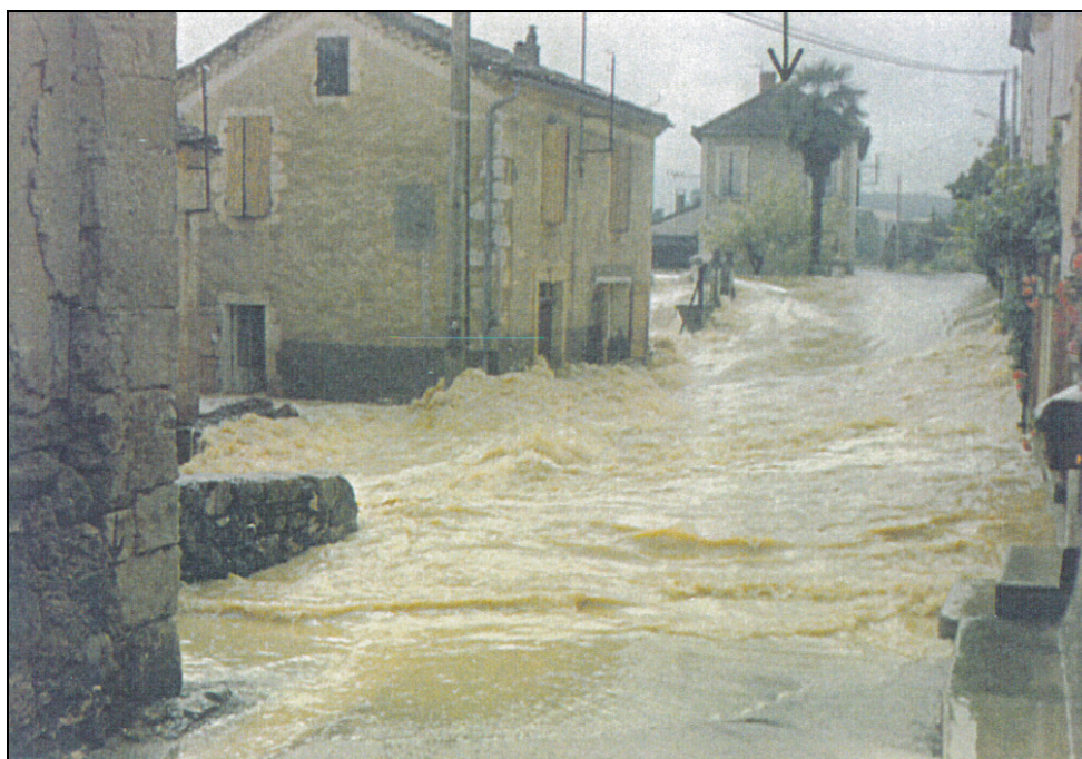
Figure n° 3 : Sur la photo on voit les courants qui empruntent la route du Stade en contournant la digue pour envahir le centre de Montestruc.
