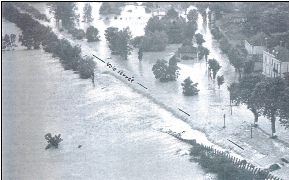
Figure n° 4 : Vue aérienne de la crue du 8/07/1977 à Montestruc - A cet endroit, la voie ferrée traverse la vallée du Gers en remblai. Le remblai est submergé et la photo met en évidence le rehaussement de la ligne d'eau (surcote) qu'il provoque côté amont.
